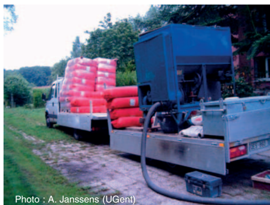
Fig. 23 Réservoir de stockage et compresseur pour le dosage d'un isolant fibreux.
