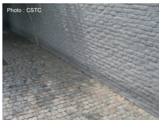
Fig. 26 Séchage plus lent au pied d'une maçonnerie soumise à des projections d'eau.
