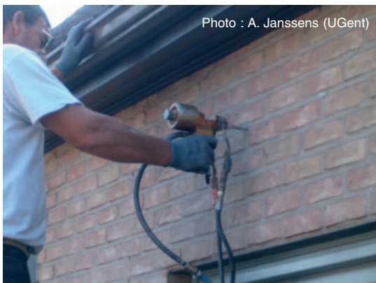
Fig. 24 Postisolation d'une façade à l'aide d'un pistolet d'injection.
