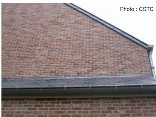
Fig. 5 Maçonnerie de parement soignée dont le jointolement est en bon état.
